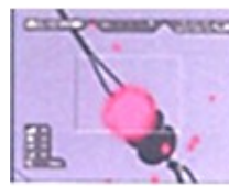
Рис. 5: N = 33560 имп./мин, а нулевых изоляторов нет. По-видимому свежая трещина в среднем изоляторе не снижает сопротивление изолятора
