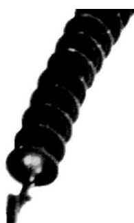
Рис. Хх. Разряды на нижнем изоляторе гирлянды ВЛ 220 кВ в сухую погоду. Получено дефектоскопом «Филин-3».
