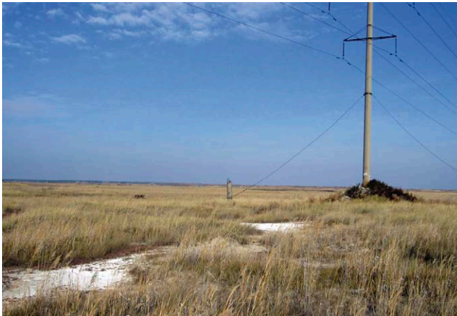
• Рис. 4. Участок ВЛ вблизи отпайки и с солончаками на почве
